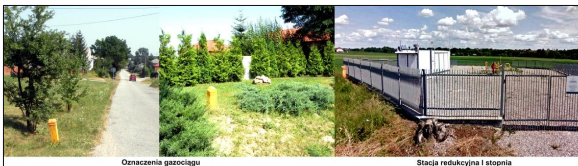
Rys. 3.19. Elementy systemu zaopatrzenia w gaz w Łęcznej
