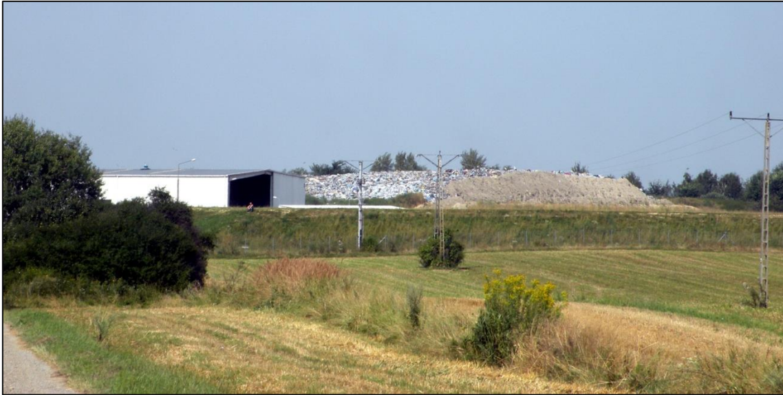
Rys. 3.15. Składowisko odpadów w Łęcznej
