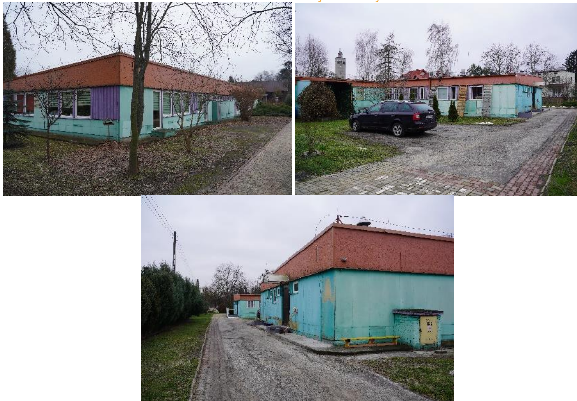
Fot. 5. Aktualny stan budynku
