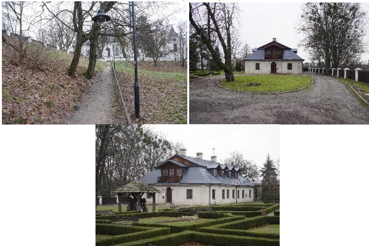
Fot. 4. Aktualny stan budynku i schodów
