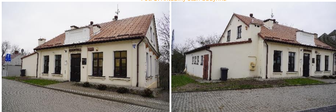
Fot. 3. Aktualny stan budynku
