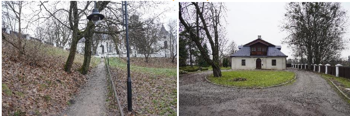
Fot. 4. Aktualny stan budynku i schodów
