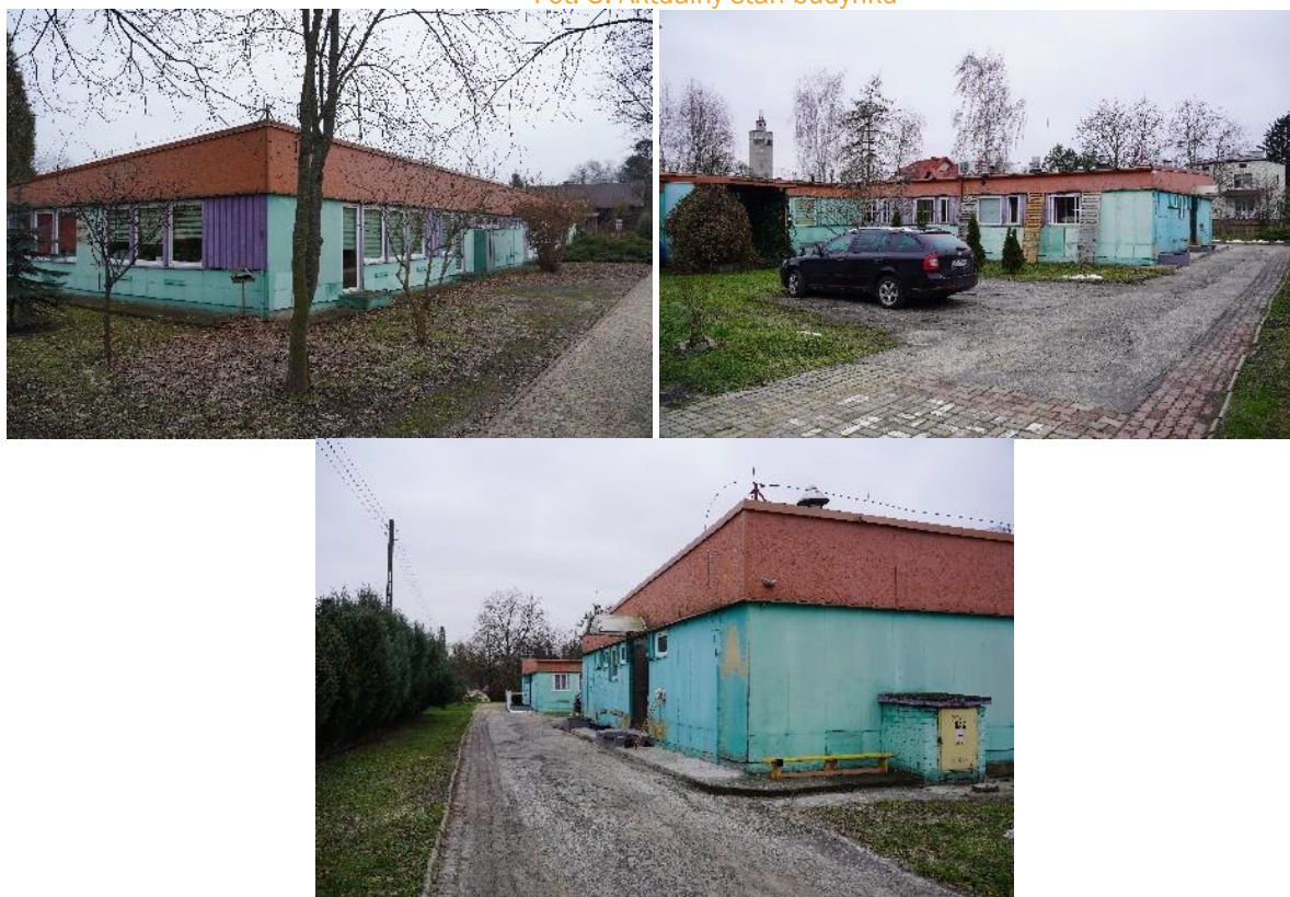
Fot. 5. Aktualny stan budynku
