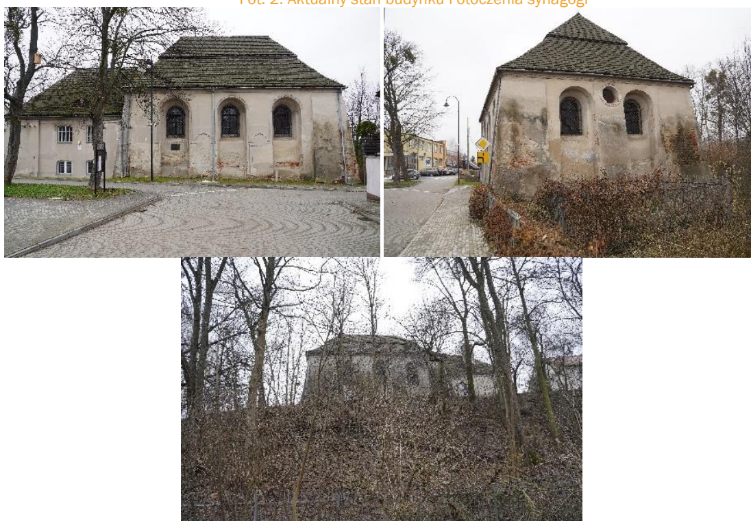
Fot. 2. Aktualny stan budynku i otoczenia synagogi
