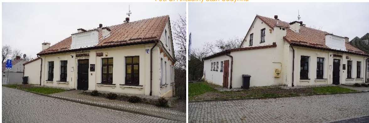
Fot. 3. Aktualny stan budynku
